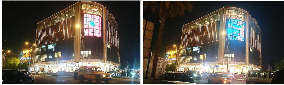
شكل(13): مبنى رقم(2) - مول باببيت (منطقة المنصور - جانب الكرخ) ، المصدر: الباحث
