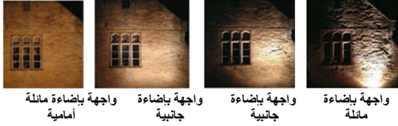
الشكل (1): يوضح التأثير المتباين على واجهات الواجهة وفقاً لطريقة تثبيت الإنارة [7]
