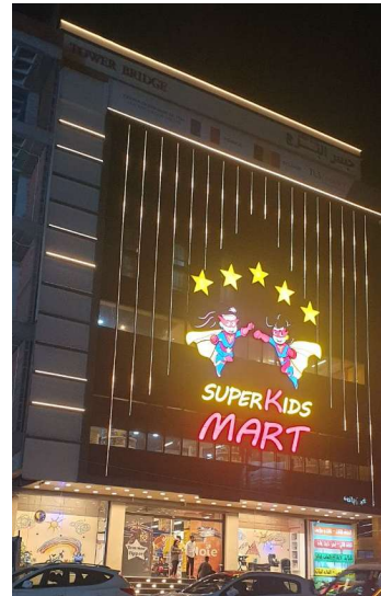
الشكل(9): مساهمة الانارة في العلامات التجارية في مبنى تجاري في شارع 14 رمضان، بغداد، المصدر: الباحث
